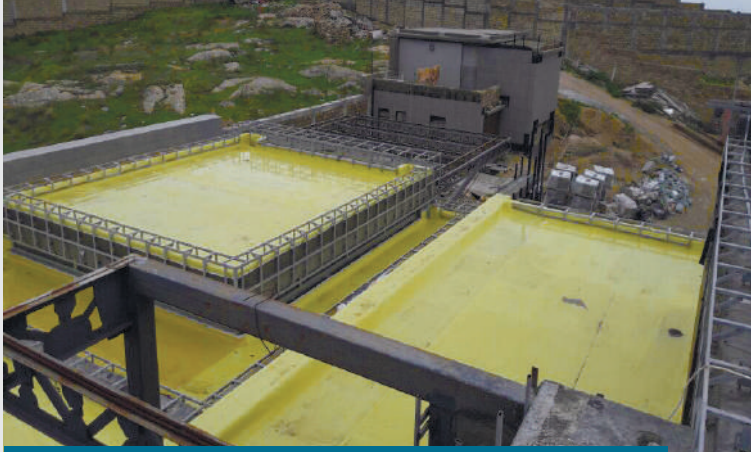
Dübəndi q. Şəxsi ev. Damın İzolyasiyası
