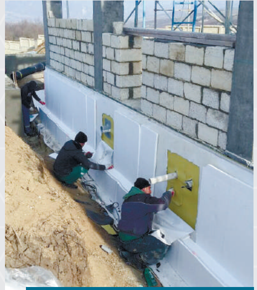
Şamaxı otel binası. Drenaj
